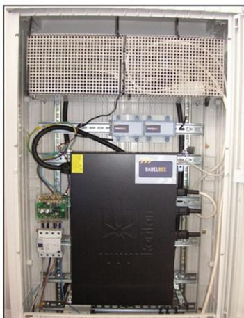
Bild 3: Der Anschlusskasten mit der Energieverteiltechnik (schwarze Box) und dem Prototypen einer PowerBee (grüne Platine links).
