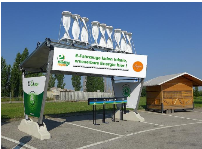
Carport: hier laden E-Fahrzeuge lokale, erneuerbare Energie
